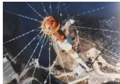
写真1 オメガナビゲーションのアンテナ鉄塔（1974年～2000年）。写真はセルフクライミングクレーンによる解体
