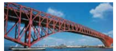
写真5 高張力鋼が大量に使用された大阪・港大橋
