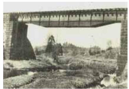
写真3 日本で最初の鉄道橋の溶接補強（奥羽線 檜山川橋梁、昭和6年、溶接補強は終戦までに1200連で行われた）
