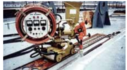
写真4 サブマージアーク溶接による橋梁の鋼床版の溶接
