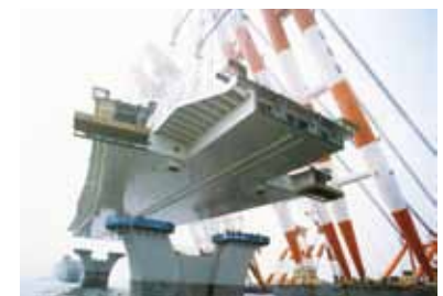
写真6 アクアライン橋梁（フローティングクレーン架設）
