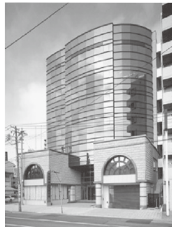
写真-1 宮城県建設業会館
